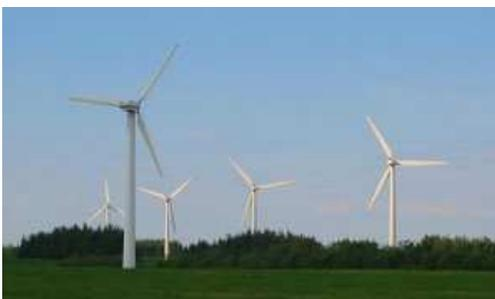
**Parque eólico.-** En la actualidad se utiliza, sobre todo, para mover aerogeneradores, que son molinos que a través de un generador producen energía eléctrica. Suelen agruparse en parques eólicos, concentraciones de aerogeneradores necesarias para que la producción de energía resulte rentable.
