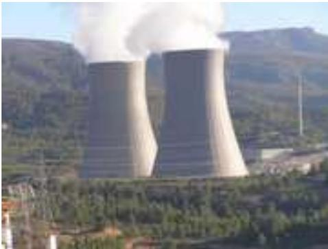
Una **central nuclear** es una instalación industrial empleada para la generación de energía eléctrica a partir de energía nuclear, que se caracteriza por el empleo de materiales fisionables que mediante reacciones nucleares proporcionan calor. Este calor es empleado por un ciclo termodinámico convencional para mover un alternador y producir energía eléctrica.
